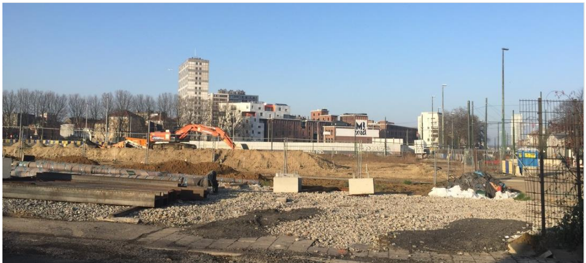
Photo 2 : Vue sur le secteur boulevard Barthélémy - (Source : Agora février 2017)
