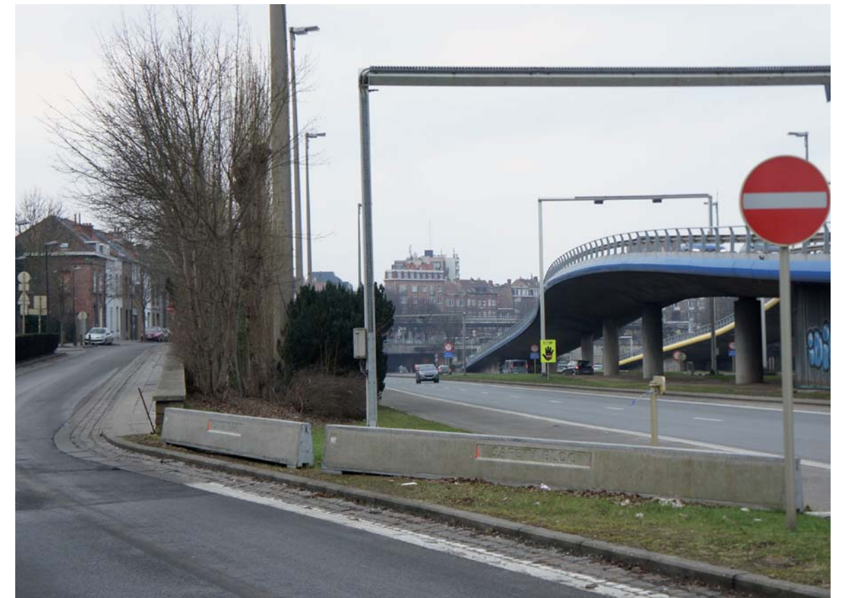
Point de contact entre l'E40 et l'architecture de la ville : la façade de Bruxelles.
