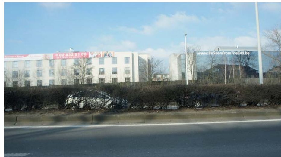
Vue de l'autoroute
