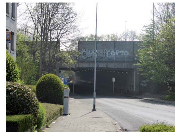
Passage sous l'E40, avenue Léon Grosjean
