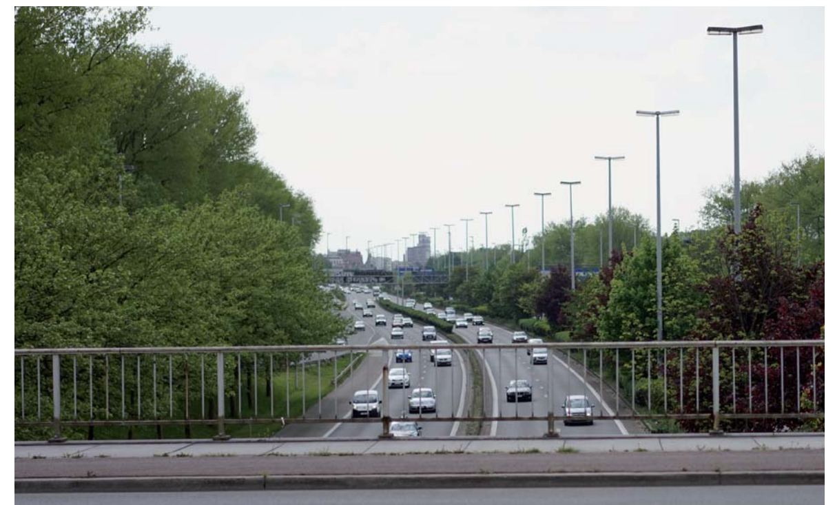
L'E40 vue depuis le pont de l'avenue des Communautés
