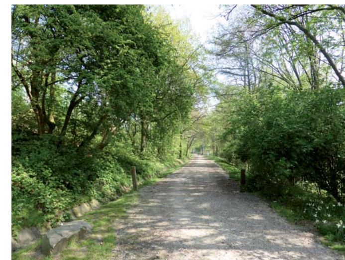
Chemin d'entretien du talus sud de l'E40
