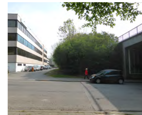
Verskillende zichten op het gebouw
