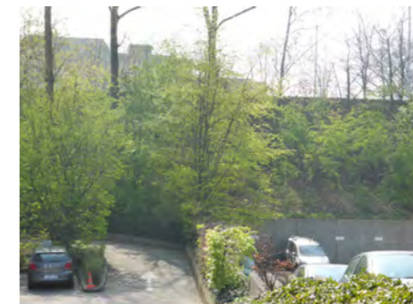
Verskillende zichten op het gebouw
