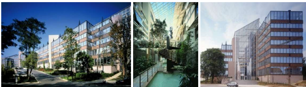
Afbeelding 392: Gebouwen aan de Beaulieulaan 1-7 (Atelier d'Architecture de Genval)
