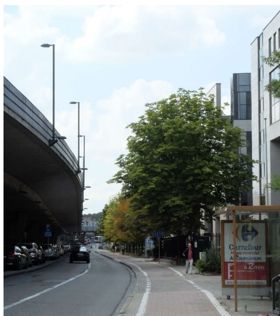
Afbeelding 455: Weg onder het viaduct richting Herrmann-Debrouxkruispunt (ARIES, 2018)
