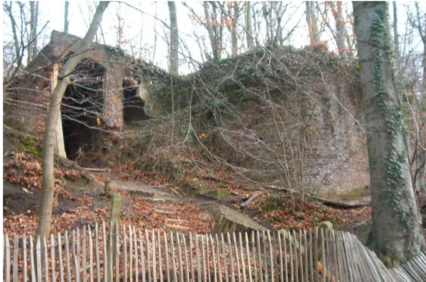
Afbeelding 460: IJskelder van het Rood Klooster (Brugis)
