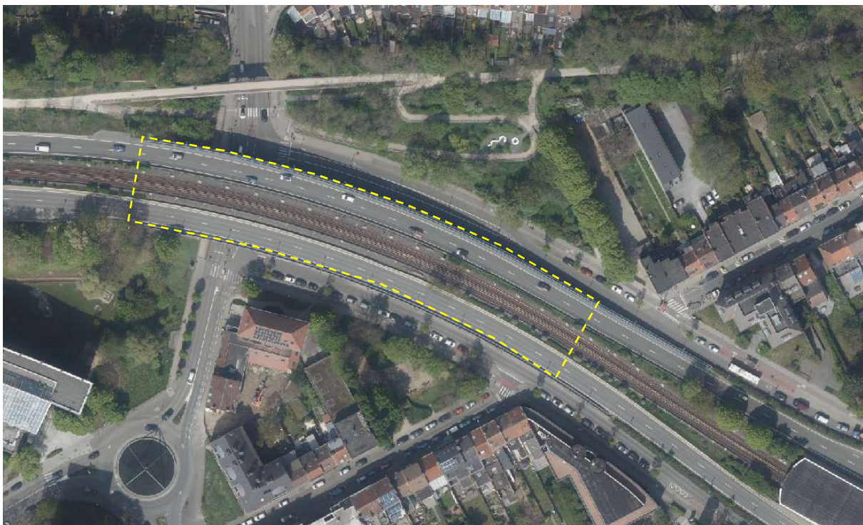
Afbeelding 304: Ligging van het viaduct van de Watermaalse Steenweg (Brugis, 2018)
