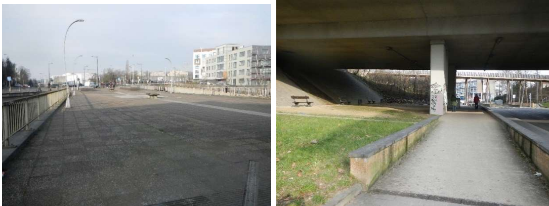
Afbeelding 411: Ongastvrije openbare ruimtes bij het metrostation Beaulieu (links) en onder het viaduct aan de Watermaalse Steenweg (rechts) (Antea, 2018)
