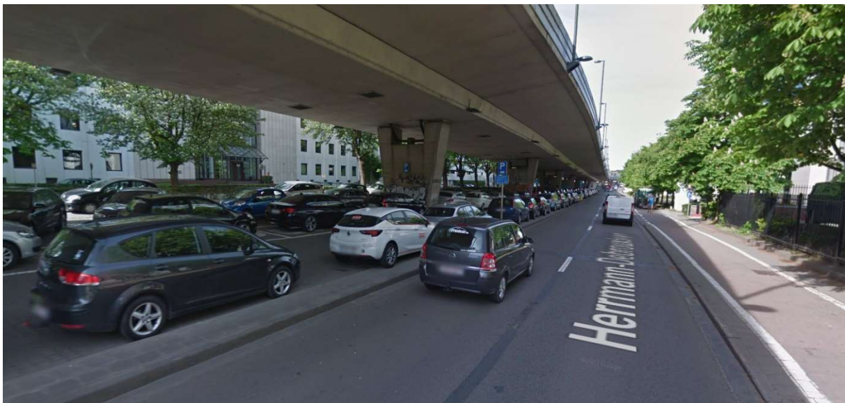
Figure 500 : Ombrage généré par le viaduc Herrmann-Debroux (Google Streetview, mai 2017)
