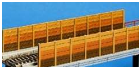
Figure 788 : Mur antibruit « en couloir »
