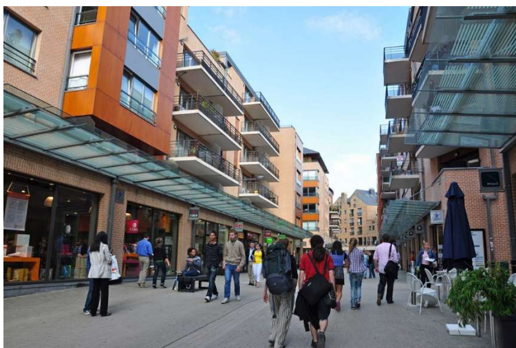
Figure 859 : Vue de la rue Charlemagne bordée de gabarits R+3 et R+4 (mtab, 2018)
