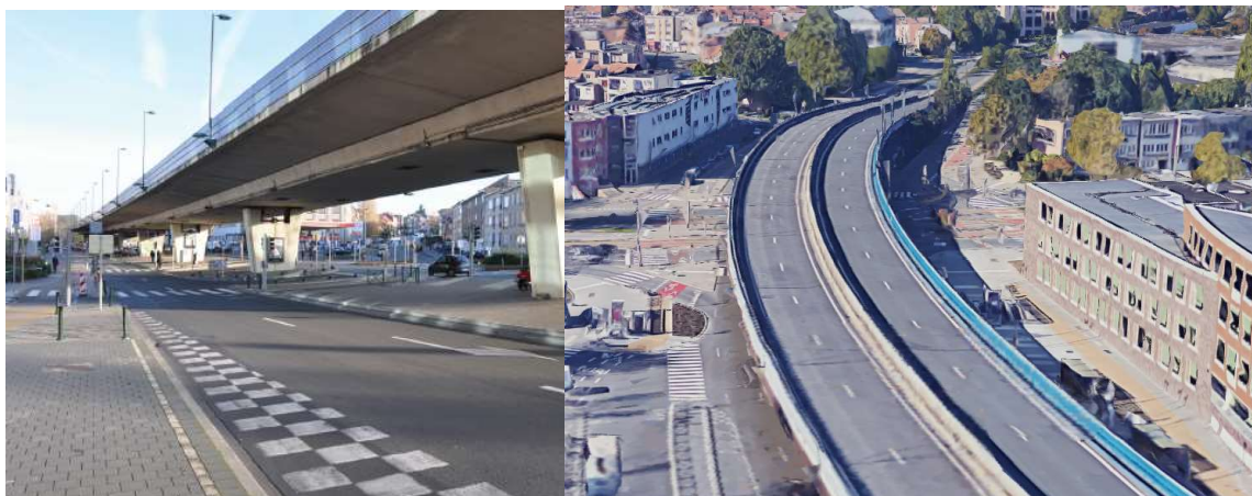
Figure 623 : Viaduc en situation existante (ORG 2 ,2019 ; Google Maps, 2019)
