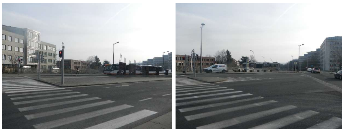
Figure 373: Traversée de plusieurs bandes à hauteur de l'Avenue de Beaulieu (Antea, 2018)
