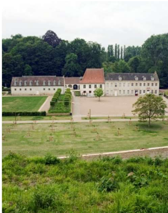
Figure 462 : Ancien prieuré du Rouge-Cloître (Bruxelles Urbanisme et patrimoine)
