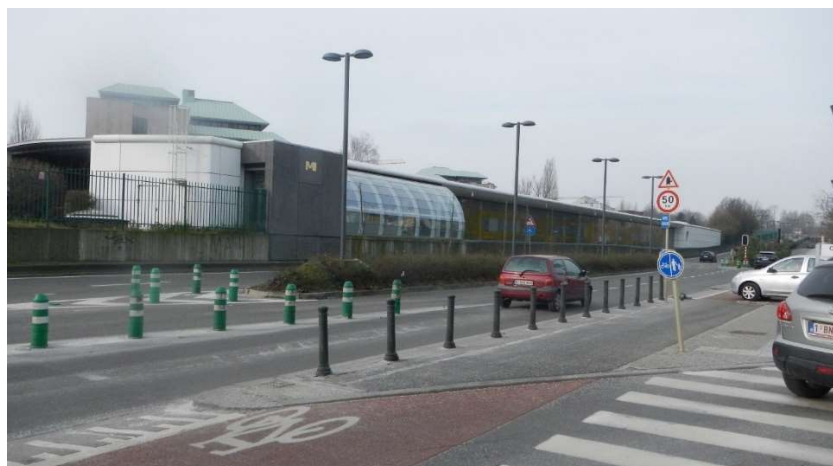
Figure 174 : Vue de la station de métro Demey (Antea, 2017)
