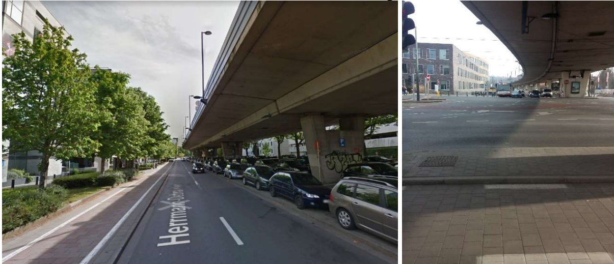
Figure 303: Ombre sur l'espace public du côté nord du viaduc Herrmann-Debroux (à gauche : Google Street View, mai 2017 ; à droite : Antea, février 2018)
