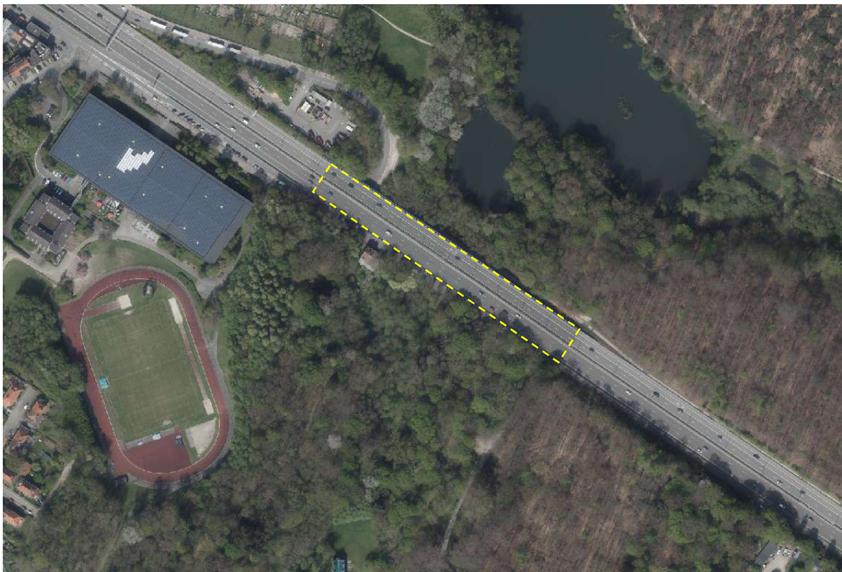
Figure 300 : Localisation du viaduc des Trois Fontaines (Brugis, 2018)
