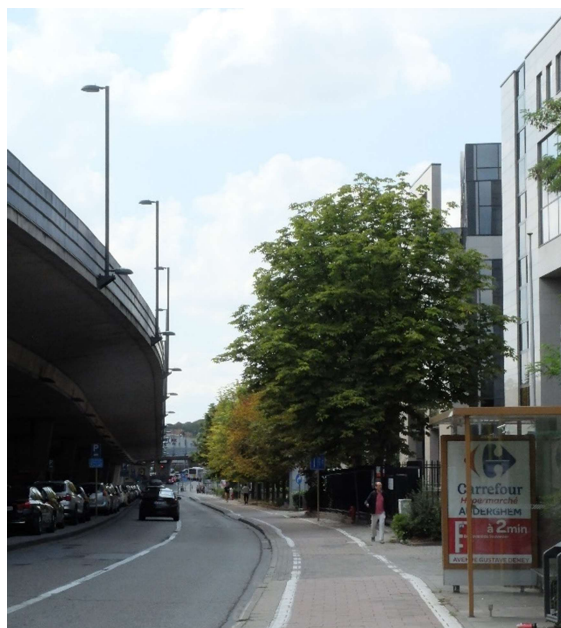
Figure 458 : Voirie en contre bas du viaduc vers le carrefour Herrmann-Debroux (ARIES, 2018)
