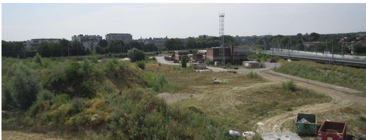
Figure 391 : Vue du site Triangle depuis l'esplanade du CHIREC (ARIES, 2018)
