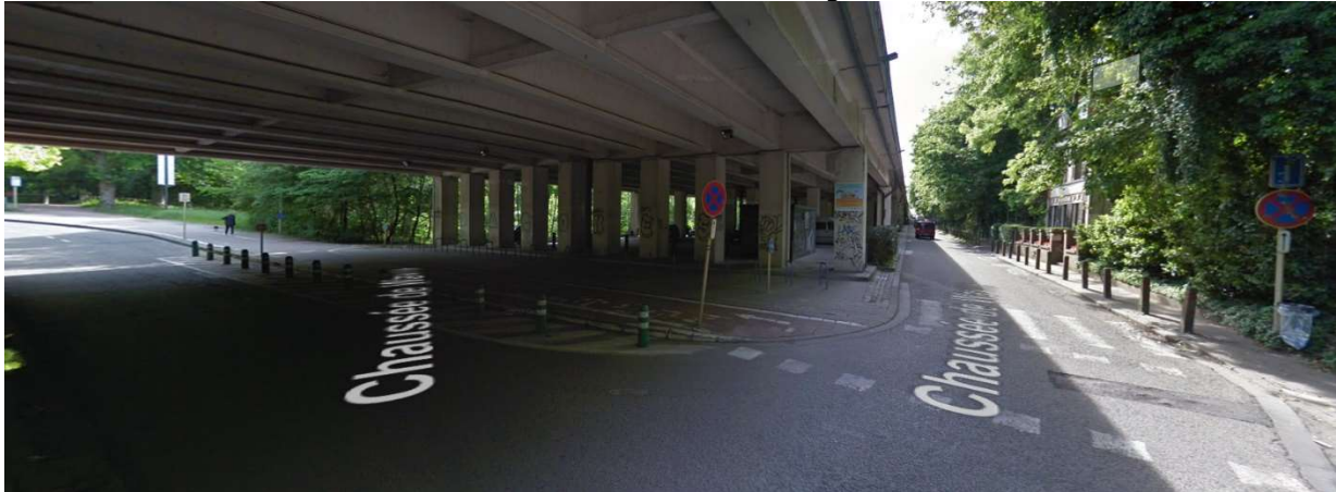
Figure 301 : Ombre en-dessous du viaduc des Trois Fontaines (Google Street View, 2017)
