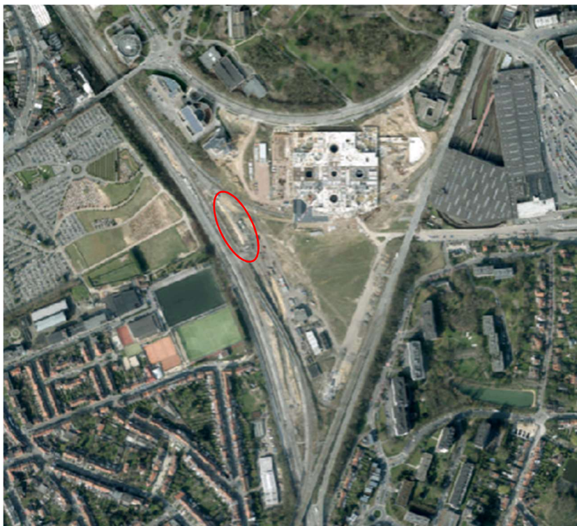
Figure 322: Localisation du bassin d'orage d'Infrabel (Bruciel, orthophotoplan 2015)
