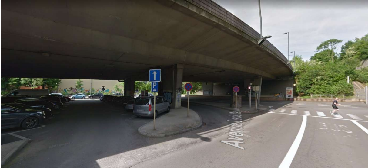
Figure 305 : Ombrage sous le viaduc de la chaussée de Watermael (Google Streetview, 2017)
