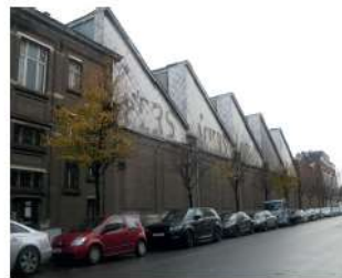
Bâtiment industriel (van wezel)
