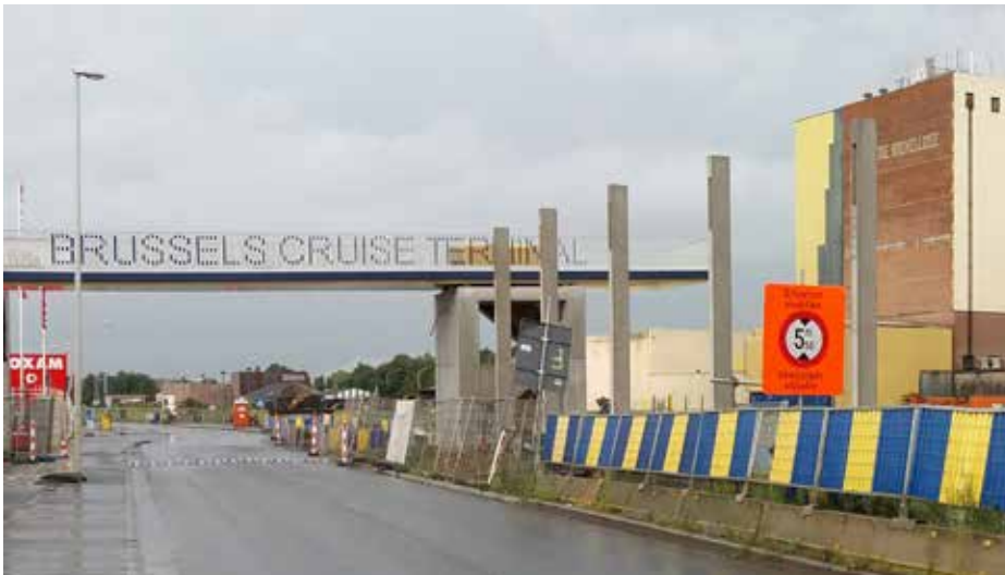
construction du brussels cruise terminal - septembre 2017
