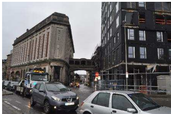
Foto 39: Brouwerij Vandenheuveel (Foto: ABO)
