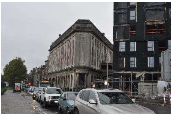
Foto 38: Brouwerij Vandenheuveel (Foto: ABO)
