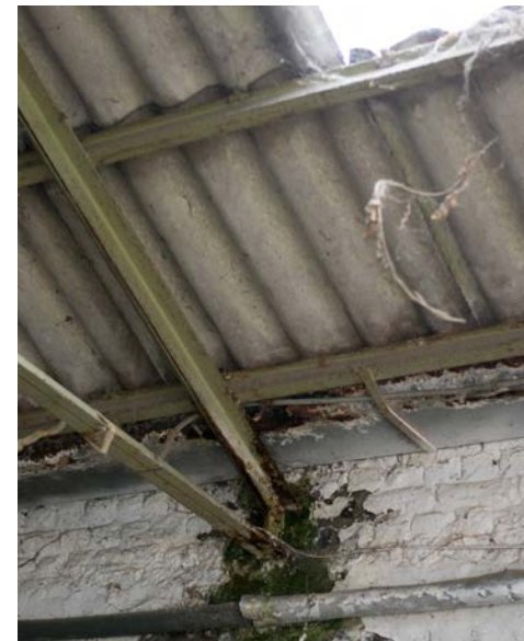
↑ Détail de la charpente métallique Detail van het metalen structuur
