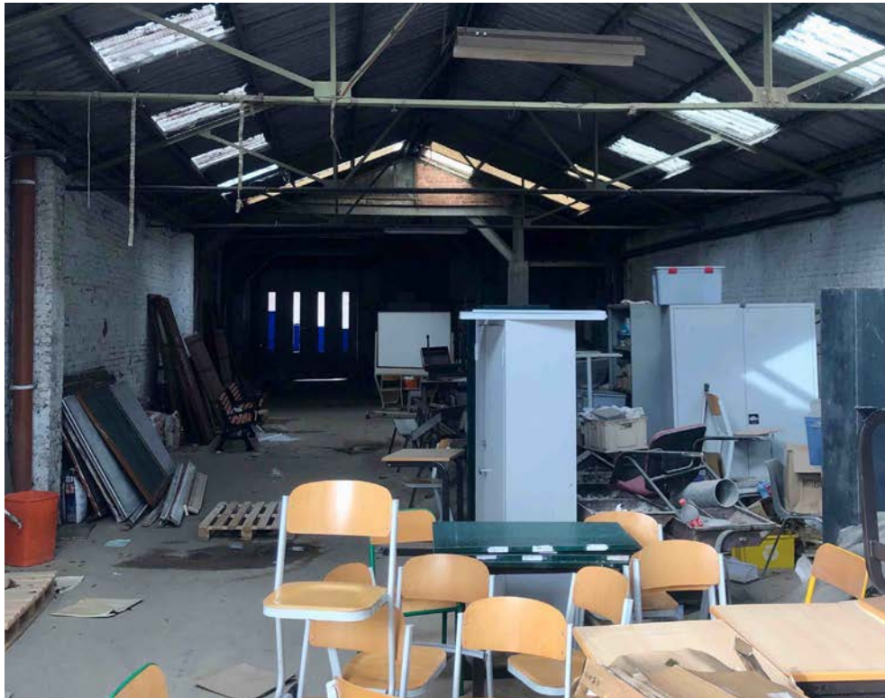
↑ Intérieur du hangar In de hangar
