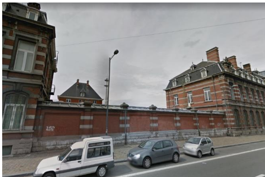
Figure 31 : Vue de l'enceinte au droit du bd Général Jacques (Google street view, 2014)
