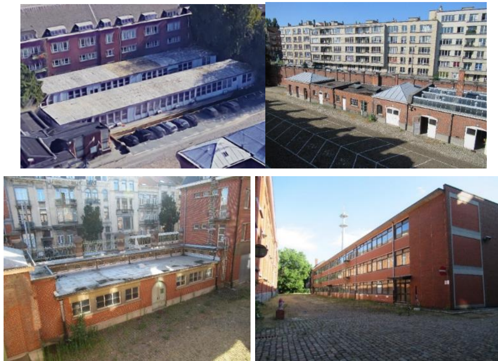
Figure 206 : Bâtiments démolis dans le scénario 1 : (de gauche à droite et de haut en bas) X et Z, P, J' et E (Google Maps & ARIES, 2017)
