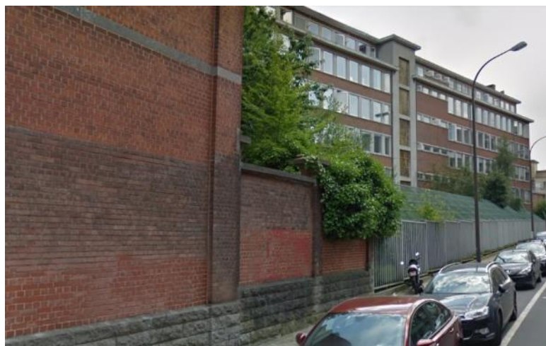
Figure 33 : Vue de l'enceinte au droit de la rue F. Toussaint (Google street view, 2014)
