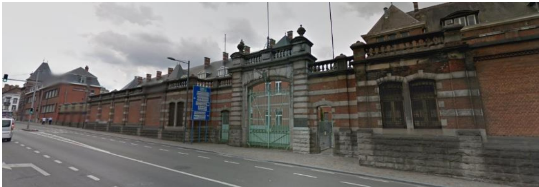
Figure 32 : Vue de l'enceinte au droit de l'av. de la Couronne (Google street view, 2014)
