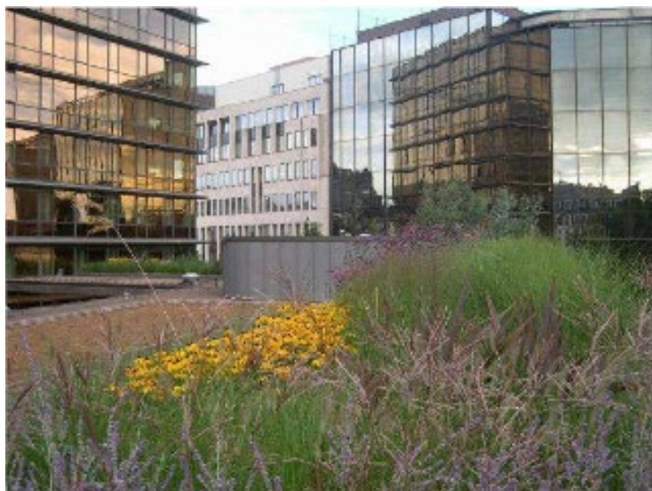
Figure 332 : Toiture semi-intensive, immeuble de bureaux à Ixelles (Arch-paysagiste : Bernard Capelle 2003)
