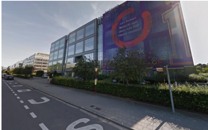
Figure 24 : Bâtiments de bureaux, boulevard de la Plaine (Google Street View, 2014)
