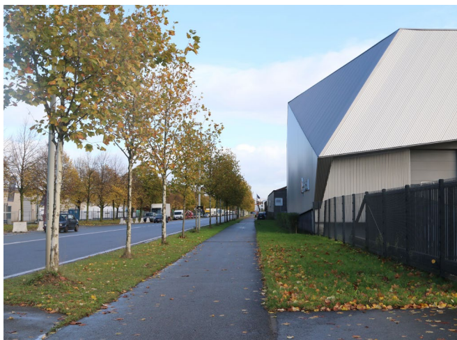
Foto van de bestaande situatie - tracédeel «laan»
