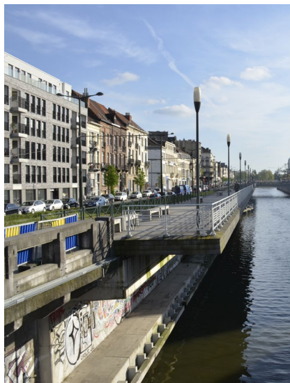
10. Stedelijke kademuur met uitkraging
