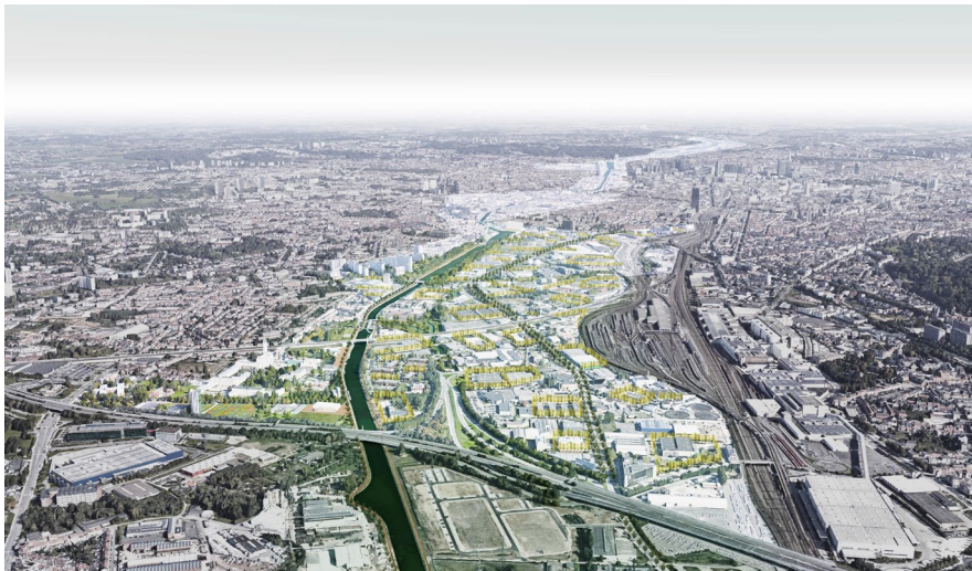
Kamerlandschap in het zuiden van het kanaalgebied
