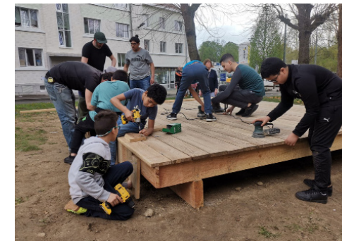
↑ Atelier de construction de mobilier, ASBL Fabrik Meubelmakerij, VZW Fabrik
