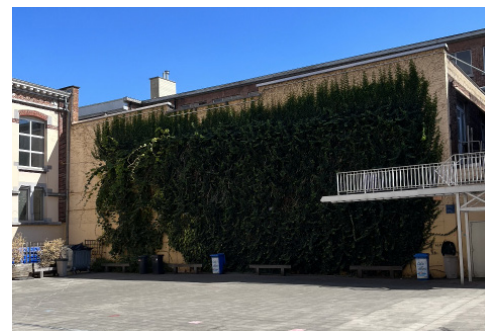
↑ Le mur existant / bestaande muur;
