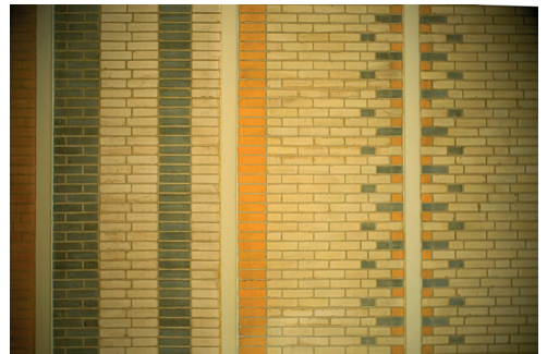
↓ Plafond de la salle de conférence | Plafond van de vergaderruimte
