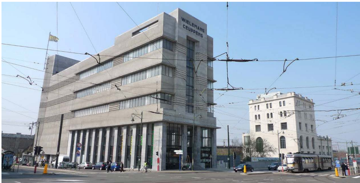
Illustration 5 : Photo des bâtiments subsistants de l'ancienne brasserie Wielemans Ceuppens
