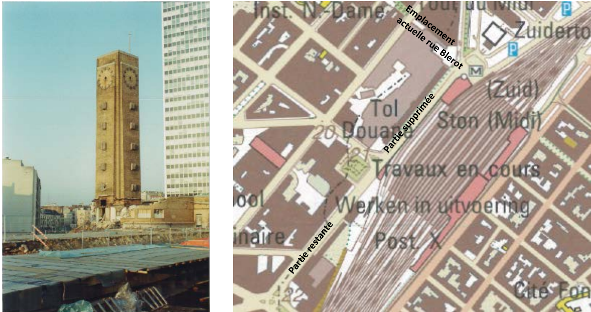
Illustration 17 : Démolition de la tour horloge et plan IGN de 1994 permettant de visualiser l'ancienne rue de France
