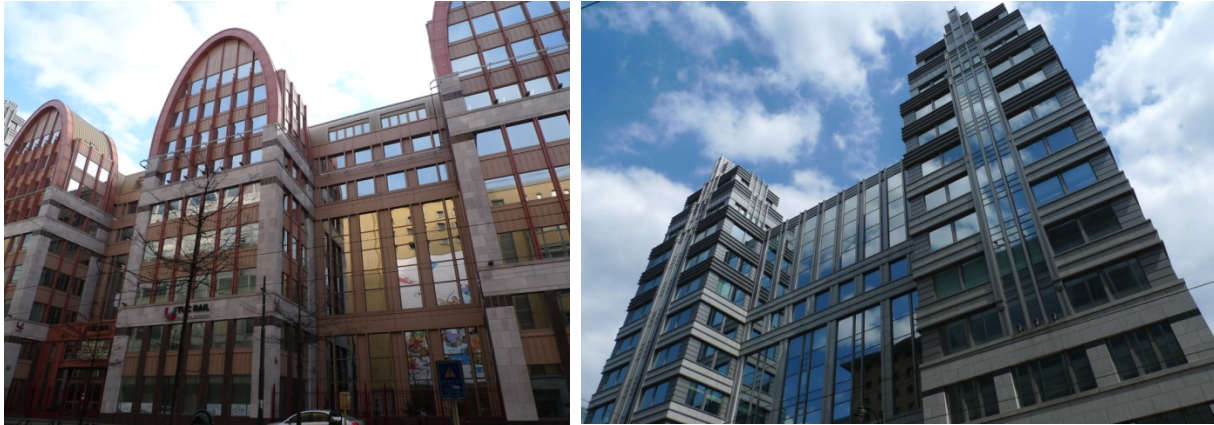
Illustration 20 : Réalisations de bureaux sur l'avenue Fonsny
