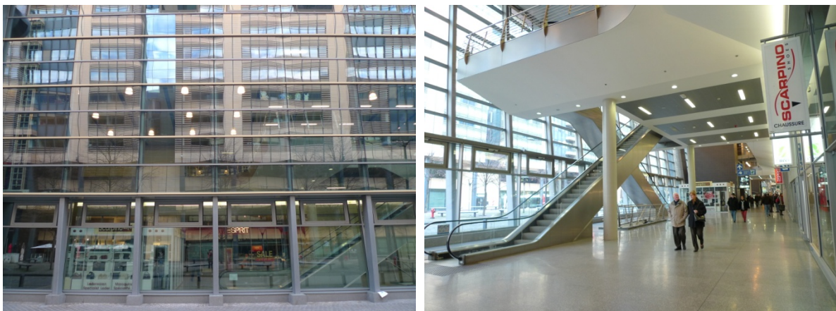
Illustration 48 : Vues extérieure et intérieure de la galerie longeant la place Horta
