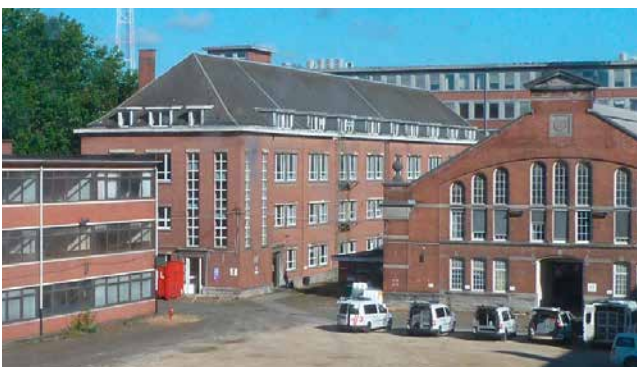
Huidige situatie gebouw I
