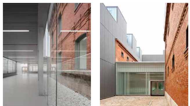
Renovatie van een voormalige gevangenis, burgerlijk centrum, Palencia, ES
