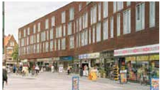
Activering van de benedenverdieping (S333, Groningen, NL)
