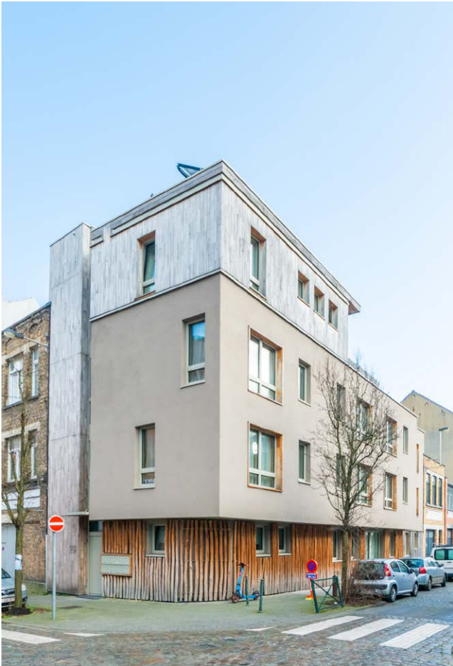
↑ Photos 2 et 3 : Campine façade (en haut), espace de vie commun (en bas) ©perspective.brussels/Pedro Correa
