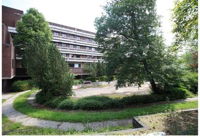
Situation actuelle - Plant d'eau inutilisé
