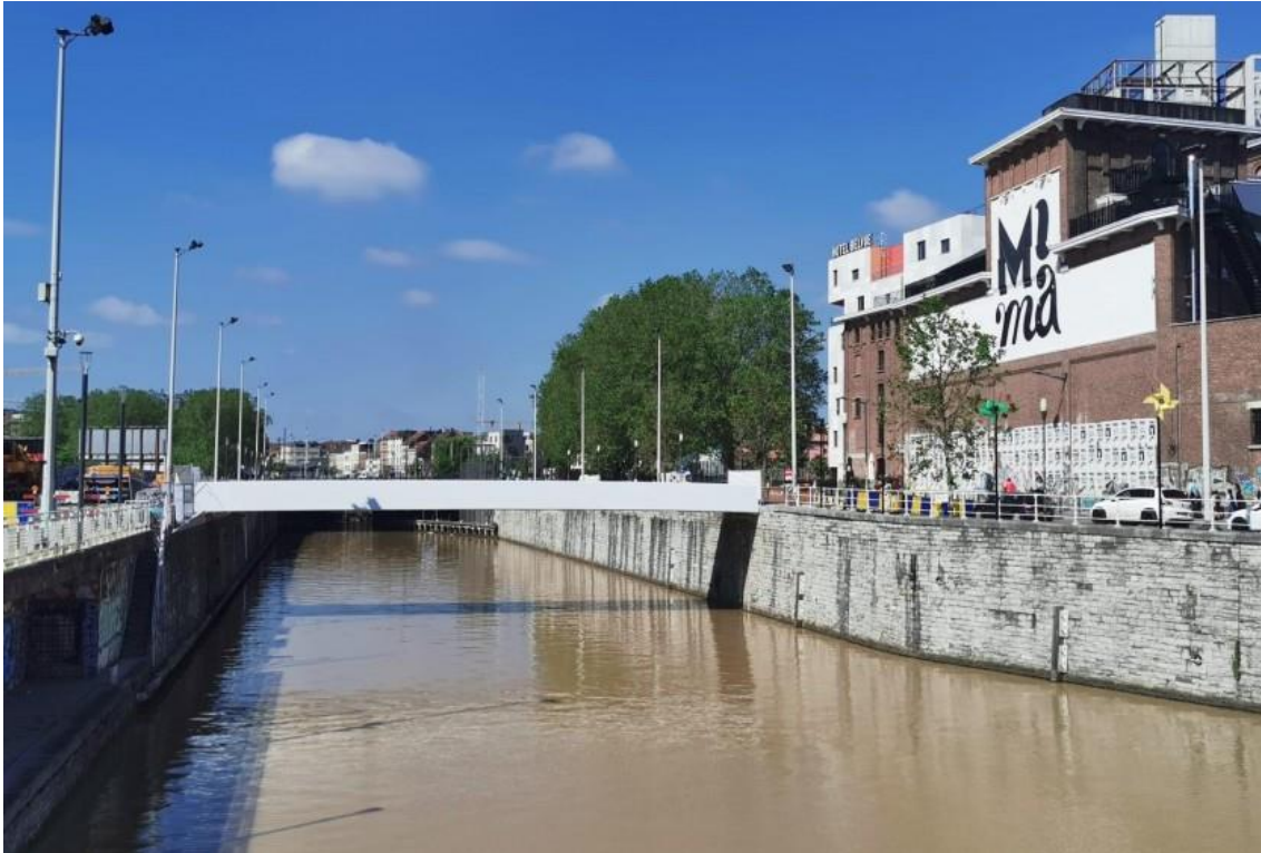
Figure 14 : Nouvelle passerelle cyclo-piétonne (Beliris, 2022)
