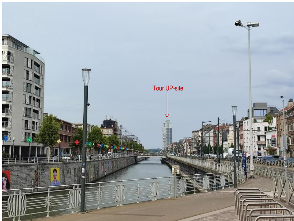
Figure 22 : Vue vers le nord-est le long du canal, avec la tour UP-site en fond de plan (ARIES, 2022)
