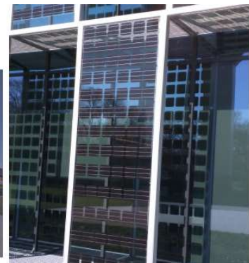
Figure 227 : Panneaux photovoltaïques en façade (BIPV) (Exemples)
