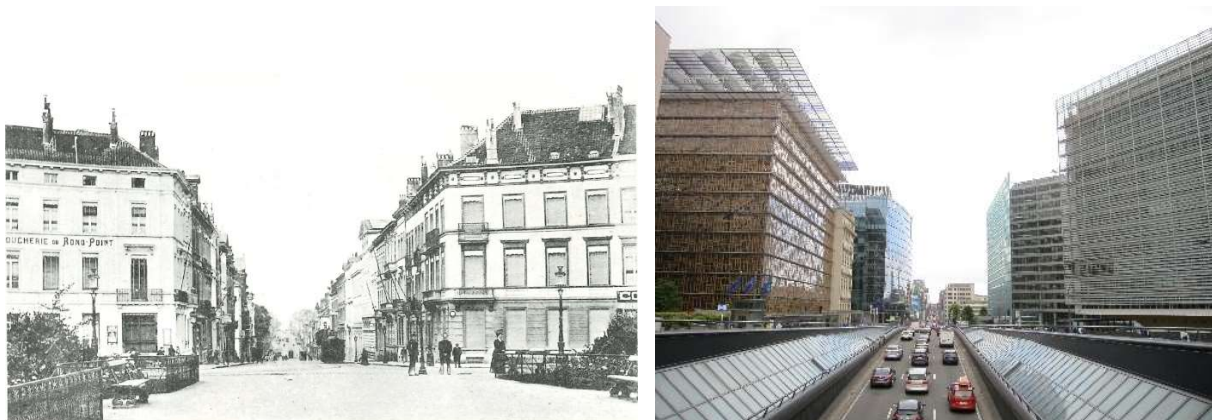
Figure 64 : Rue de la Loi depuis le rond-point Schuman : à gauche, seconde moitié du XIX ème siècle (Archives de la Ville de Bruxelles ; extrait de Leblicq, 1973) ; à droite, situation existante (ARIES, 2018)
