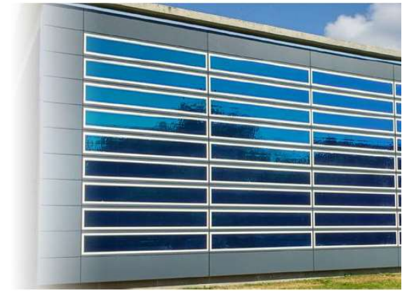
Figure 226 : Panneaux photovoltaïques en façade (BIPV) (Exemples)
