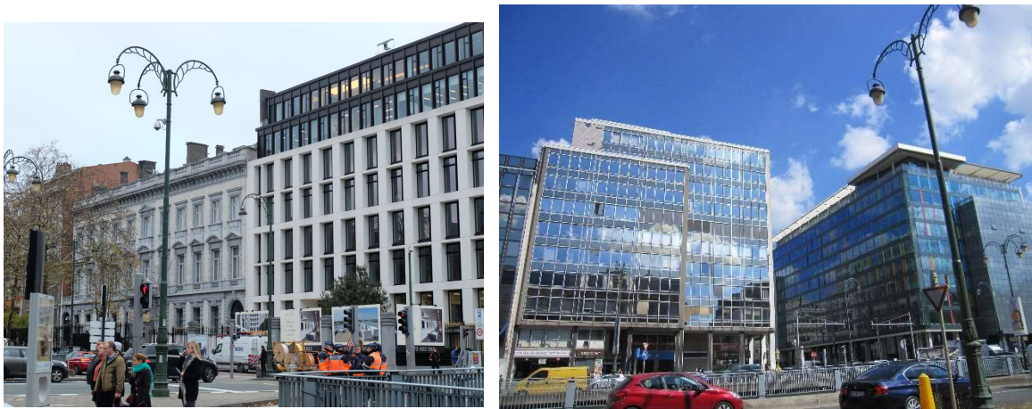
Figure 130 : Bâtiments sur l'avenue des Arts : côté quartier Royal (à gauche) et côté PAD (à droite) (ARIES, 2018)
