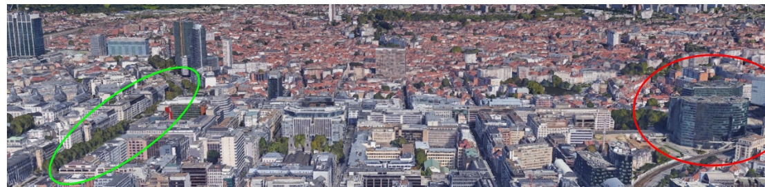
Vue aérienne (Google Earth Pro) du site du projet depuis le Sud
