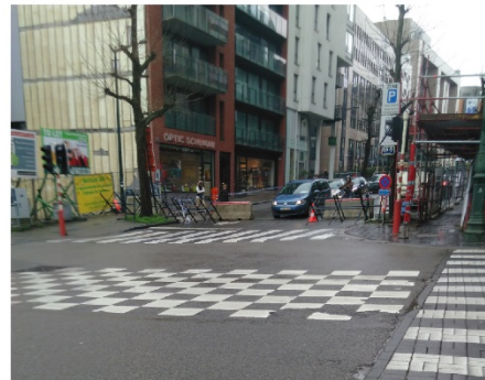
Figure 18 : Dispositif de sécurité sur le croisement entre la rue Froissart et la rue Belliard lors de la première phase de sécurisation (fermeture partielle)
