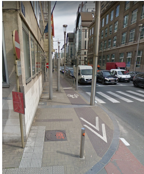
Figure 4 : Vue sur l'un des trottoirs de la rue de la Loi au droit de traversée piétonne
