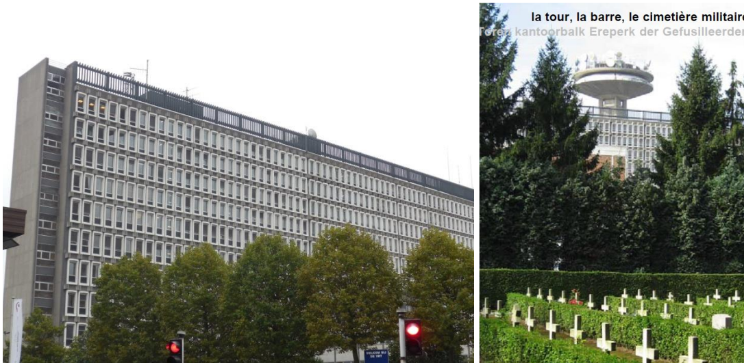
Huidige gebouwen van de RTBF - VRT
