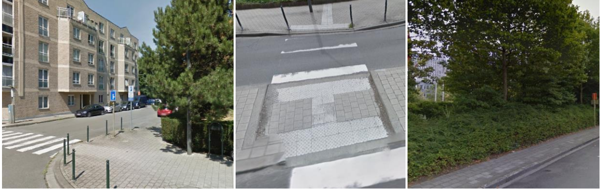
Kolonel Bourglaan en ventweg aan de Reyerslaan - brede voetpaden, doorlopende verharding die in goede staat verkeert, aanwezigheid van paaltjes voor de veiligheid van voetgangers op het kruispunt, podotactiele tegels
