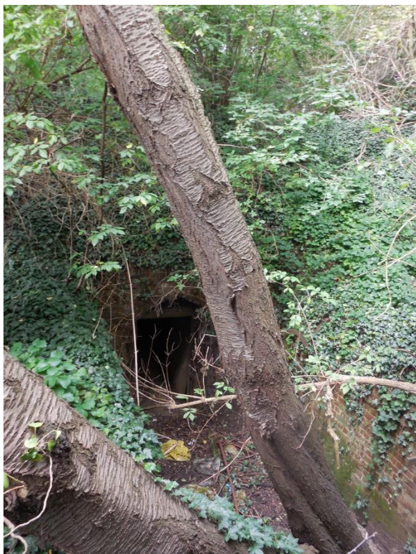
Uitzicht op een sleuf aan de voet van het talud
