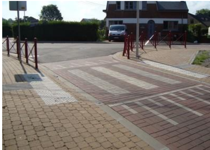
Figure 49 : Traversée adaptée aux PMR (Gamah, 2015)
