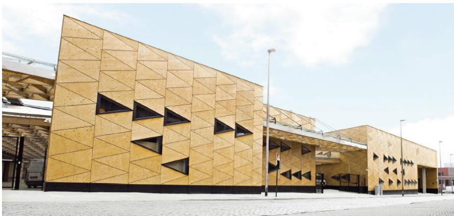
Figure 27 : Exemple de typologies productives à caractère urbain à Tivoli (Greenbizz, Architectes Associés, mo Citydev.Brussels)
