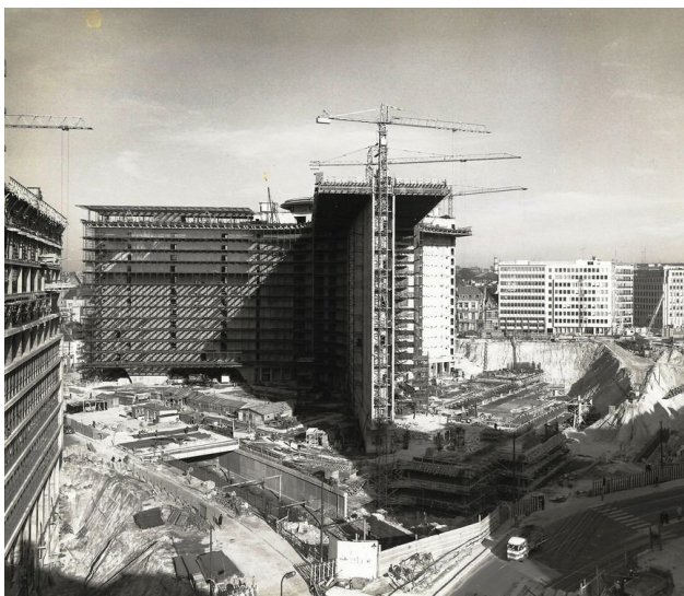
Construction du bâtiment Berlaymont 1964
