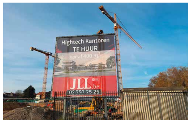
↑ Bouwplaats van het kantoorparkproject 'Hightech Kantoren' 2020 © perspective.brussels
