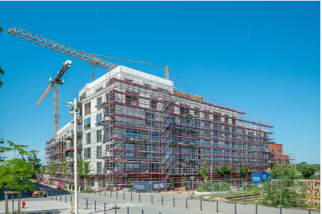
↑ Projet Erasmus Garden : construction d'un ensemble d'immeubles à appartements sur une importante réserve foncière, avenue des Hortensias, Anderlecht
