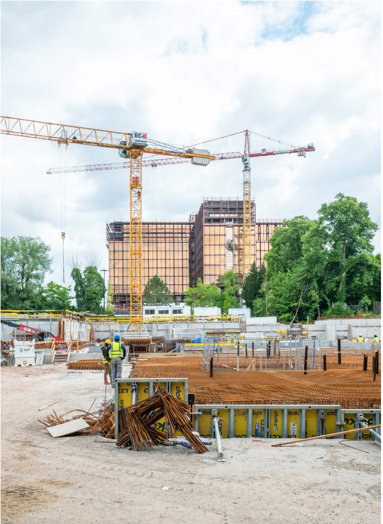
↑ Projet Royale belge : densification de la seconde couronne via la construction d'un ensemble d'immeubles à appartements et de locaux commerciaux, Avenue du Souverain, Watermael-Boitsfort
