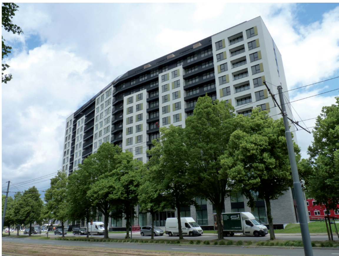
Conversion d'un immeuble de bureaux, rue de Genève. Transformatie van een kantoorgebouw, Genèvestraat. Office building conversion, Rue de Genève.
