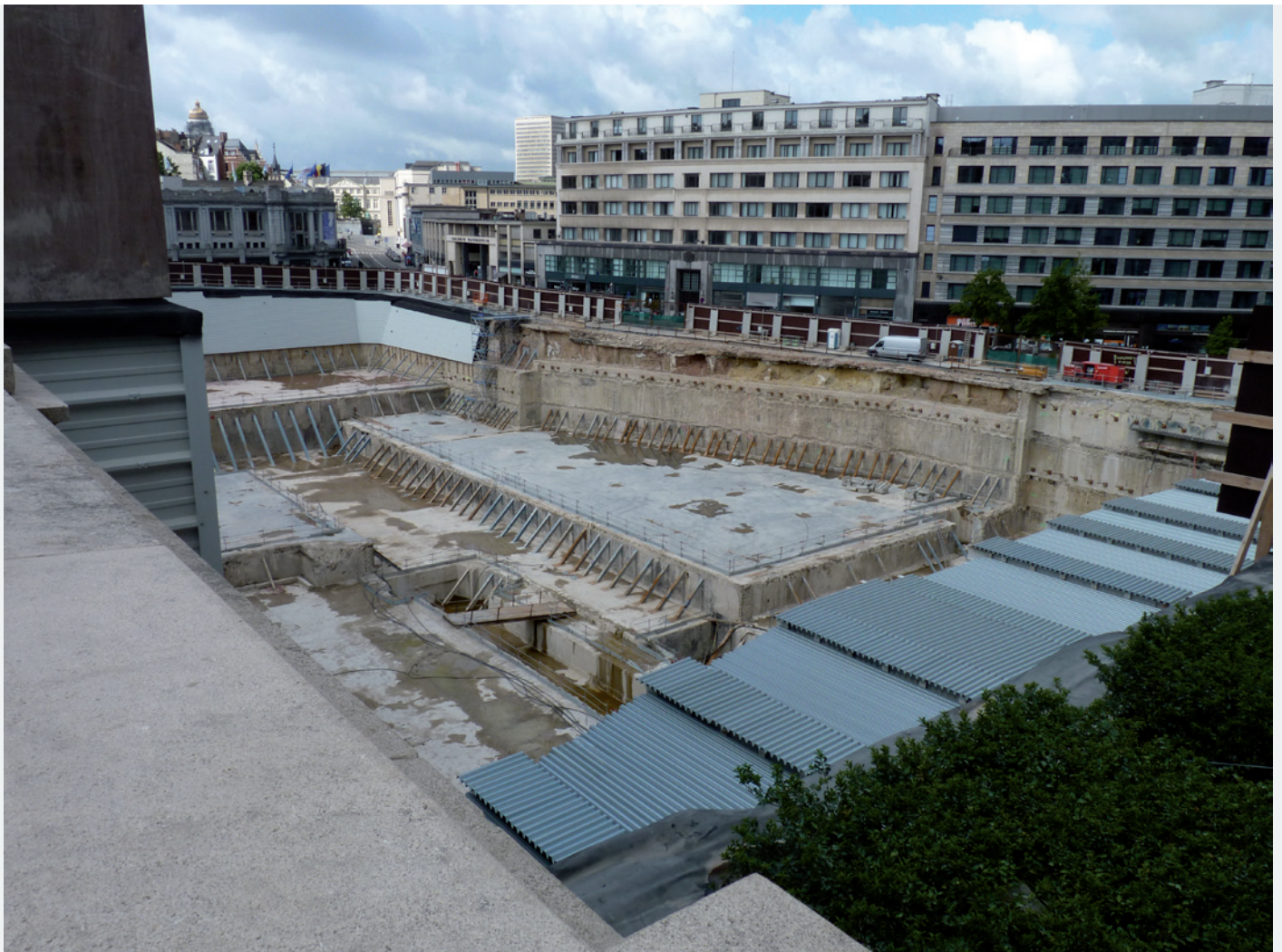
Le chantier du siège de BNP Paribas Fortis, rue Ravenstein. / De werf voor de zetel van BNP Paribas Fortis, Ravensteinstraat. / The building site of the BNP Paribas Fortis headquarters on Rue Ravenstein.
