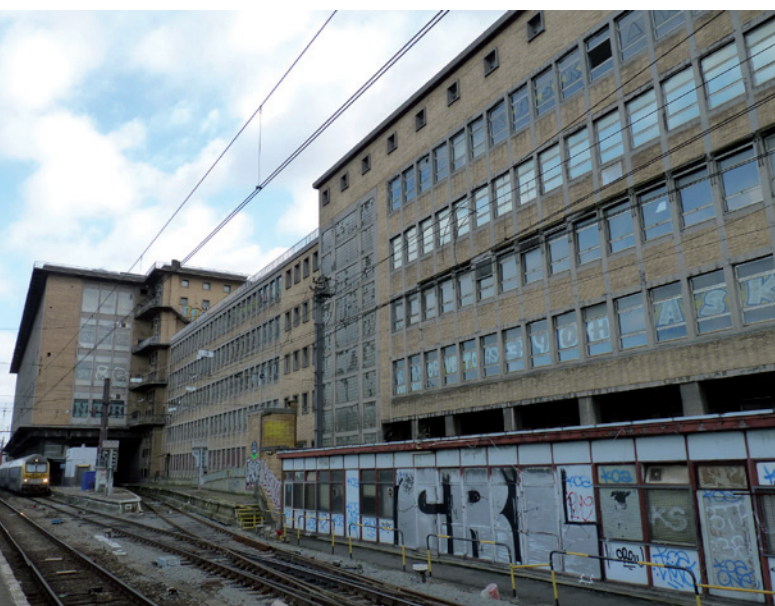
Vue de l'immeuble rue Fonsny 49 et de l'ancien Tri Postal, depuis la gare. Het gebouw in de Fonsnylaan 49 en het oude postsorteercentrum, gezien vanaf het station. The building on 49 Avenue Fonsny and the former postal sorting centre, seen from the station.
