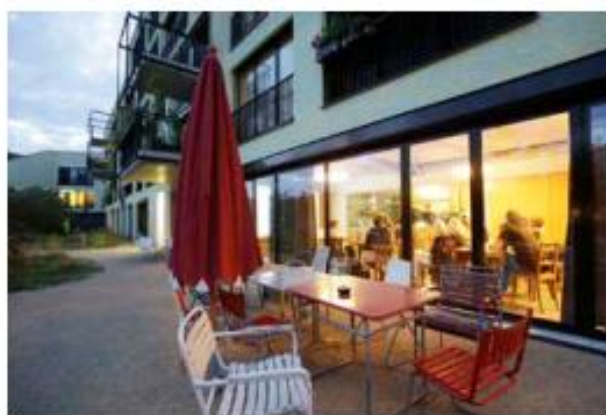
espace commun pour les habitants et visiteurs de Kalkbreite, projet de logement coopératif à Zurich
