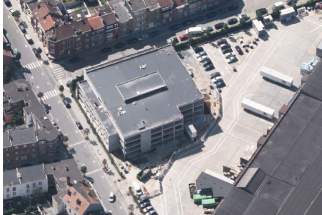
Figuur 92: Huidige situatie (gezien vanuit het noordoosten)
