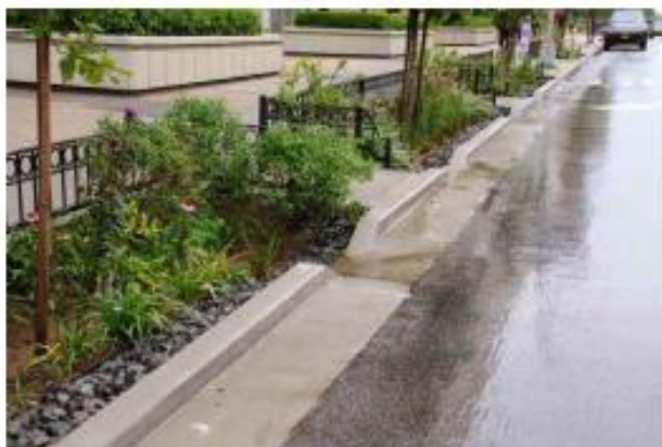
Infiltration d'eau Waterinfiltratie
