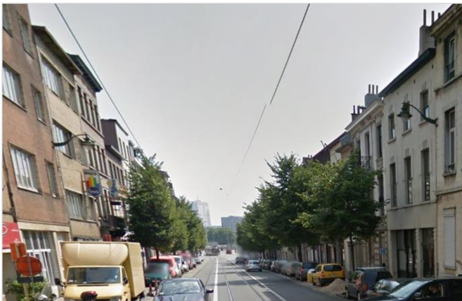
Foto 12: Zicht vanaf de Ninoofsesteenweg (Bron: Google Earth - februari 2017)
