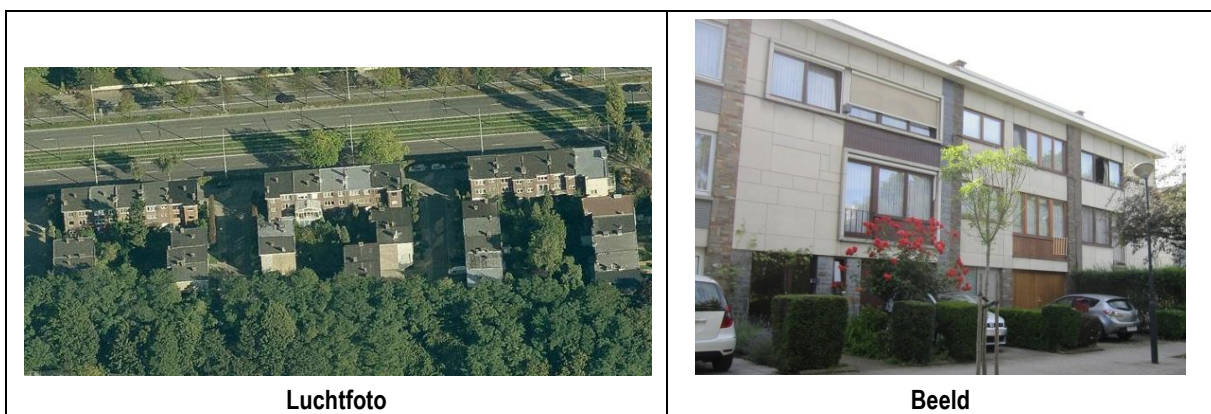
Figuur 41 : Moderne mandelige woningen (Oasisbinnenhof) in het noordoosten (Bingmaps en ARIES, 2015)
