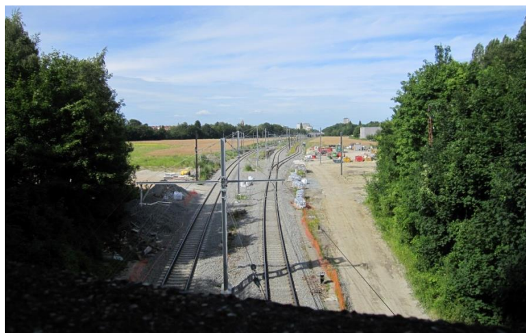
Afbeelding231: Uitzicht vanuit het plein Generaal Wahislaan naar de site over de borstwering (ARIES, 2015)
