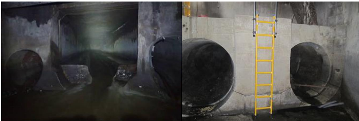
Figuur 43: Aankomst van de collector van Molenbeek in de inspectieput op de linkeroever
