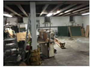
kelder en parkeerplaats
