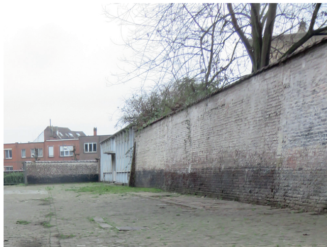
MUR DANS LA COUR (1) MUUR IN DE SPEELPLAATS (1)
