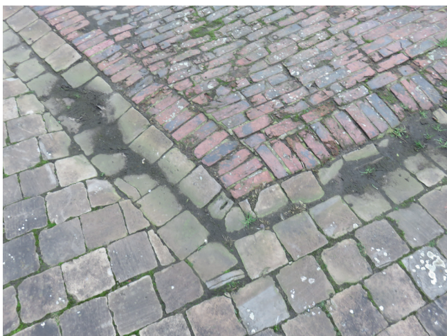
PAVÉS DE GRÈS, BRIQUES ET DALLES BÉTON (1) KASSEIEN, BASKTENEN EN BETONNEN TEGELS (1)
