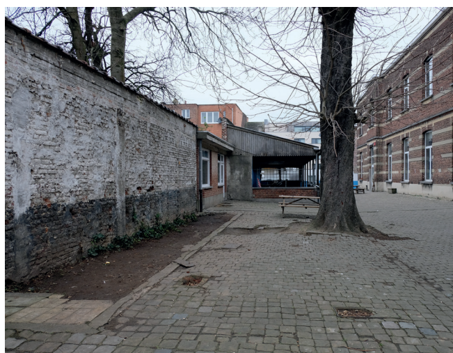
VUE DE LA COUR OUEST. LES BÂTIMENTS VOISINS SONT LARGEMENT MASQUÉS PAR LE MUR D'ENCEINTE. UITZICHT VANUIT WESTELIJKE BINNENPLAATS, NABURIGE GEBOUWEN WORDEN VERSTOPT DOOR DEZE MUUR
