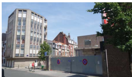
Zicht op logistieke toegang de Rudderstraat Vue sur l'accès logistique rue de Rudder
