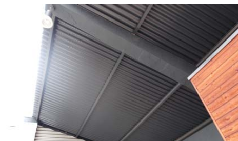
Onderzijde golfplatendak Bas du toit
