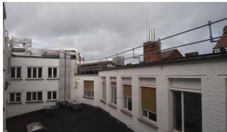
Zicht op gevel vanop het dak Vue sur la façade depuis la toiture
