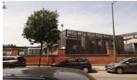
Muur gebouwd in 1934 Mur d'enceinte construit en 1934
