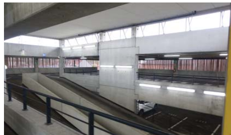
Binnenzicht- hellend vlak Vue intérieure - pente
