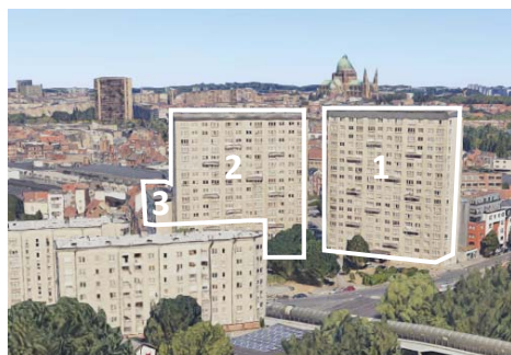
Zuidzijde - Côté Sud
