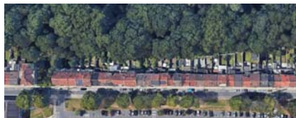
Ref. rijwoningen grenzend aan park - Boudewijnpark Réf. maisons mitoyennes adjacentes au parc - Parc Baudouin
