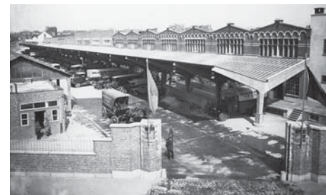
Zicht op de nieuwe luifel in 1934 Vue sur le nouvel auvent en 1934
