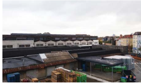
Zicht op de oude gevel aan de zuidzijde Vue sur la façade ancienne côté sud
