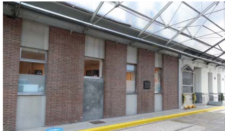
Zicht op de voorzetgevel Vue sur la façade facitice
