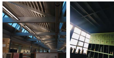
Sheddak in loods op de bovenste verdieping Oorspronkelijke betonnen constructie in de oude distilleerderij Structures de la toiture en shed au dernier étage Structure béton initiale dans l'ancienne distillerie
