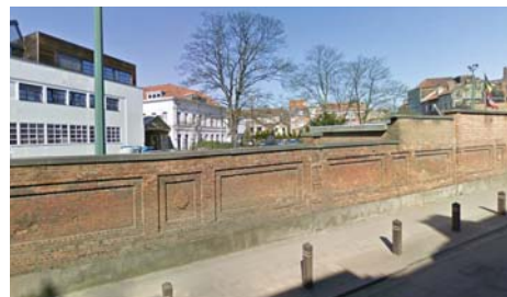
Muur gebouwd in 1885 Mur d'enceinte construit en 1885
