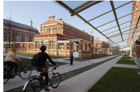
Referentiebeeld zachte verbindingen, 't Groen kwartier Antwerpen Référence des passages de mobilité douce, 't Groen Kwartier, Anvers
