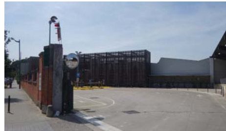
Muur gebouwd in 1934 Mur d'enceinte construit en 1934
