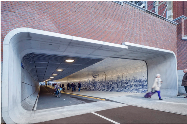
Cuyperpassage • Amsterdam • 2016 • Benthem Crouwel Architects
