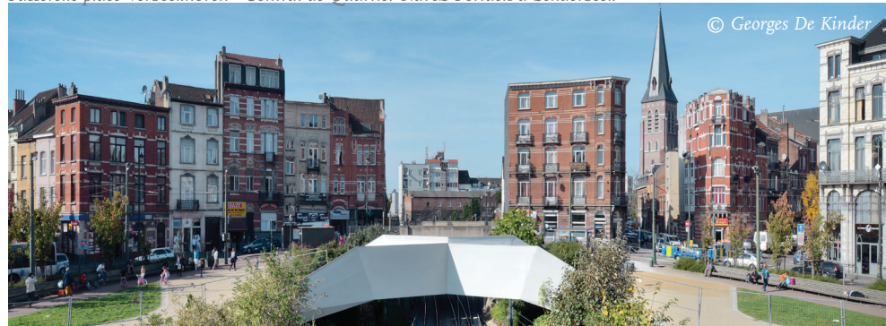
Passerelle place Verboekhoven - Contrat de Quartier Navez-Portaels à Schaerbeek
