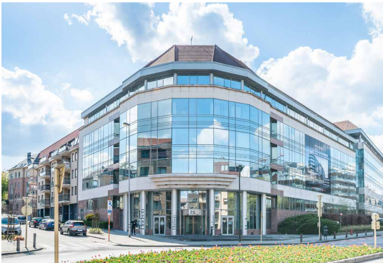
↑ Cet immeuble de l'avenue Marcel Thiry, construit en 2000, sera transformé en 107 logements et 2 commerces. Dit gebouw aan de Marcel Thiry laan, gebouwd in 2000, zal worden verbouwd tot 107 appartementen en 2 handelszaken.
