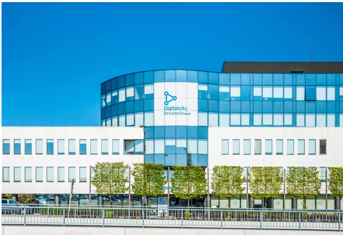
↑ Conversion en équipement de formation ICT d'un immeuble de bureaux situé à Auderghem (6 rue Jules Cockx) Reconversie van een kantoorgebouw in Oudergem (Jules Cockxstraat 6) tot ICT-opleidingsvoorziening
