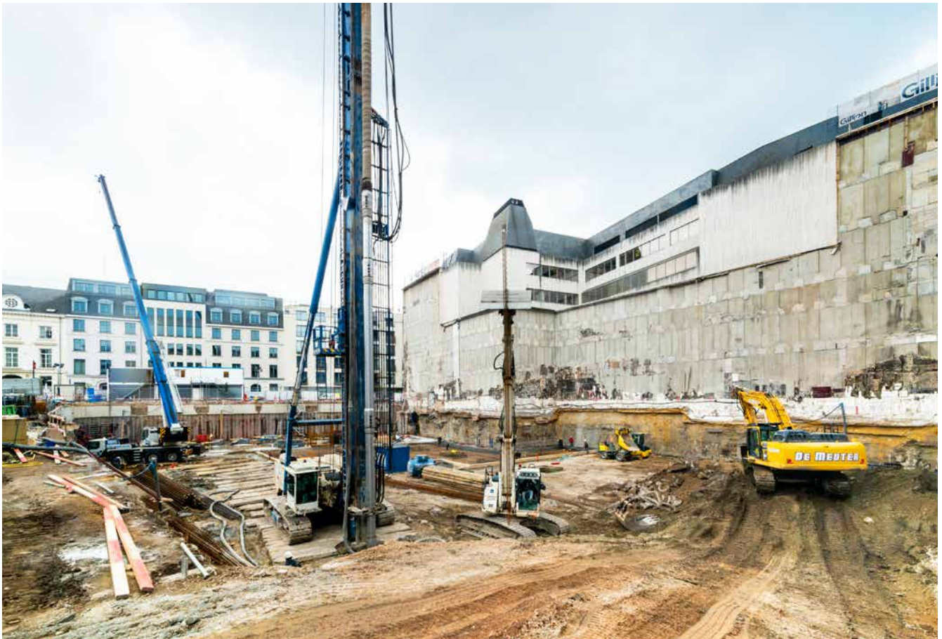
↑ Rue du Marais. Un immeuble de bureaux a été démoli pour laisser la place à des logements. Broekstraat: één kantoorgebouw werd gesloopt om plaats te maken voor woningen.
