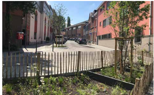
↑ Une noue sépare la chaussée du trottoir et recueille les eaux de ruissellement dans la rue Essegheem à Jette. © Suède36
