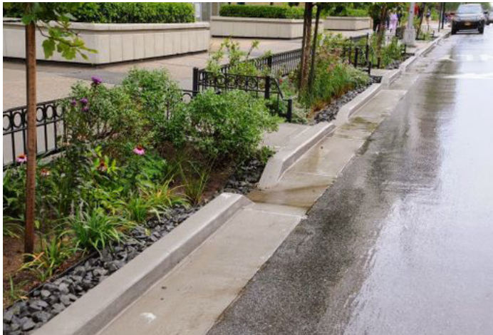
Infiltration d'eau Waterinfiltratie
