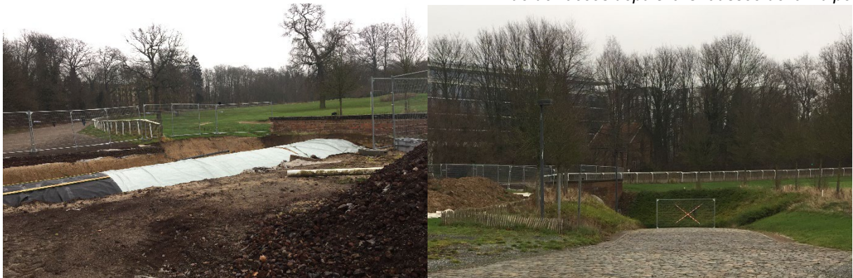
Vue du tunnel en réfection et vue depuis le golf
