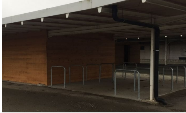
Photo 28 : Golf : accès en réfection (06/01/2021)
