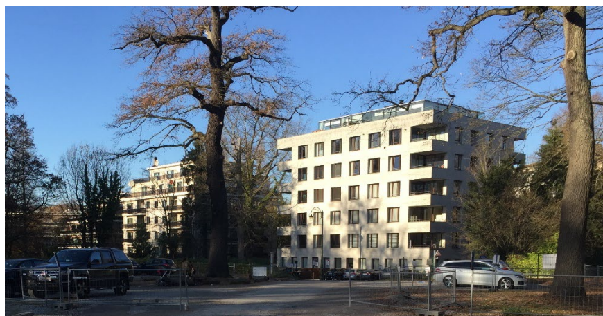
Photo 9 : Vue rapprochée sur le cadre bâti au Nord - Immeubles n°1 et 2 depuis le parking (28/11/2020)
