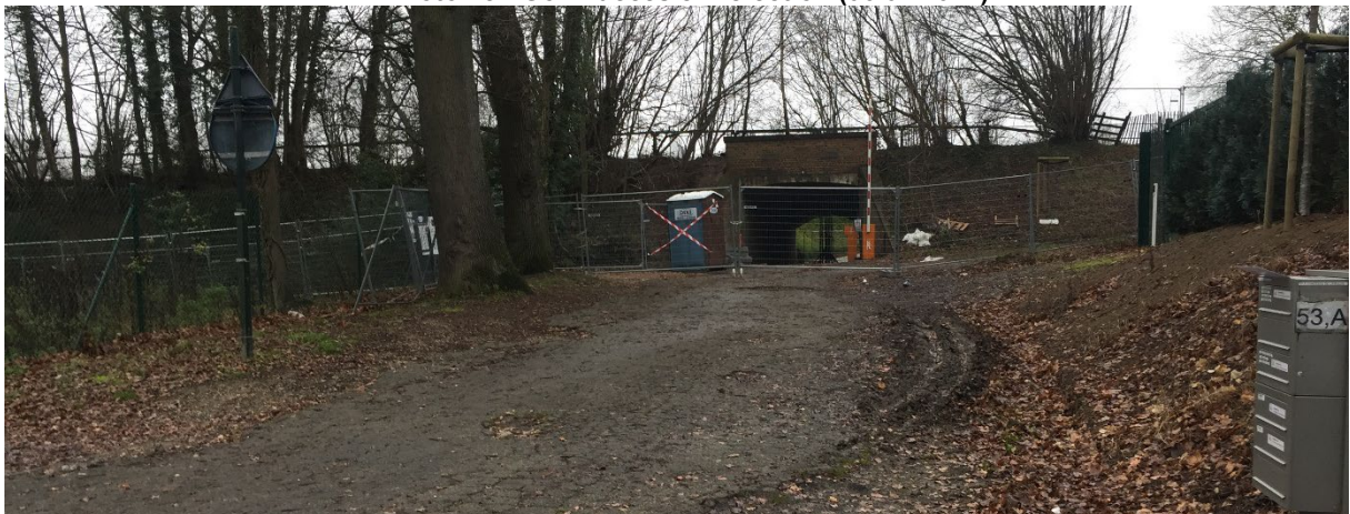
Vue de l'accès depuis la Chaussée de la Hulpe
