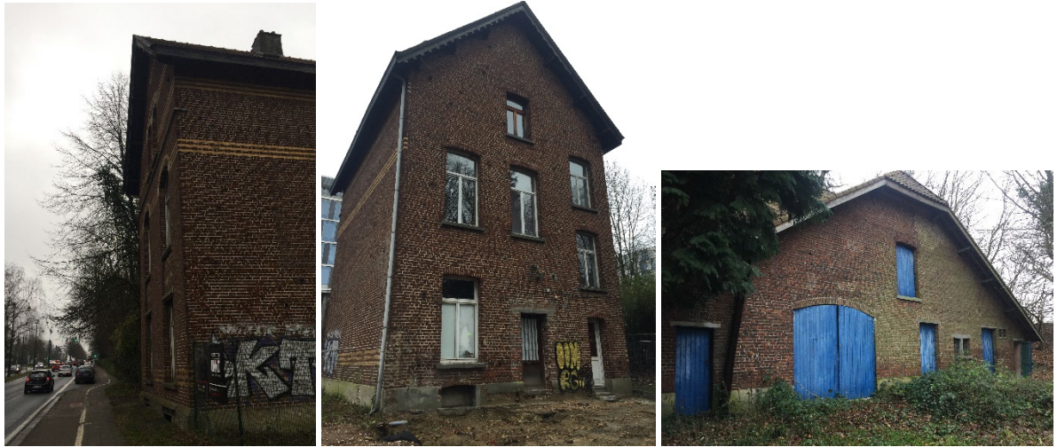
L'ancienne maison forestière 23 + annexe 24
