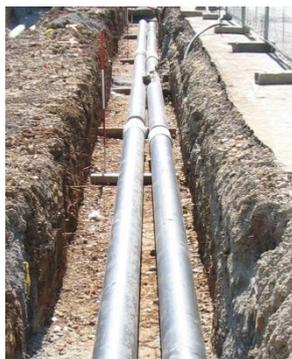
**Figure 18 : Réseau de conduites enterrées à Tübingen en Allemagne (Björn Appel, 2005)**
