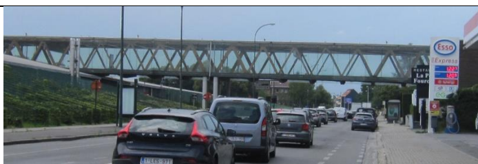
Zicht op de voetgangersbrug (ARIES, 2020)
