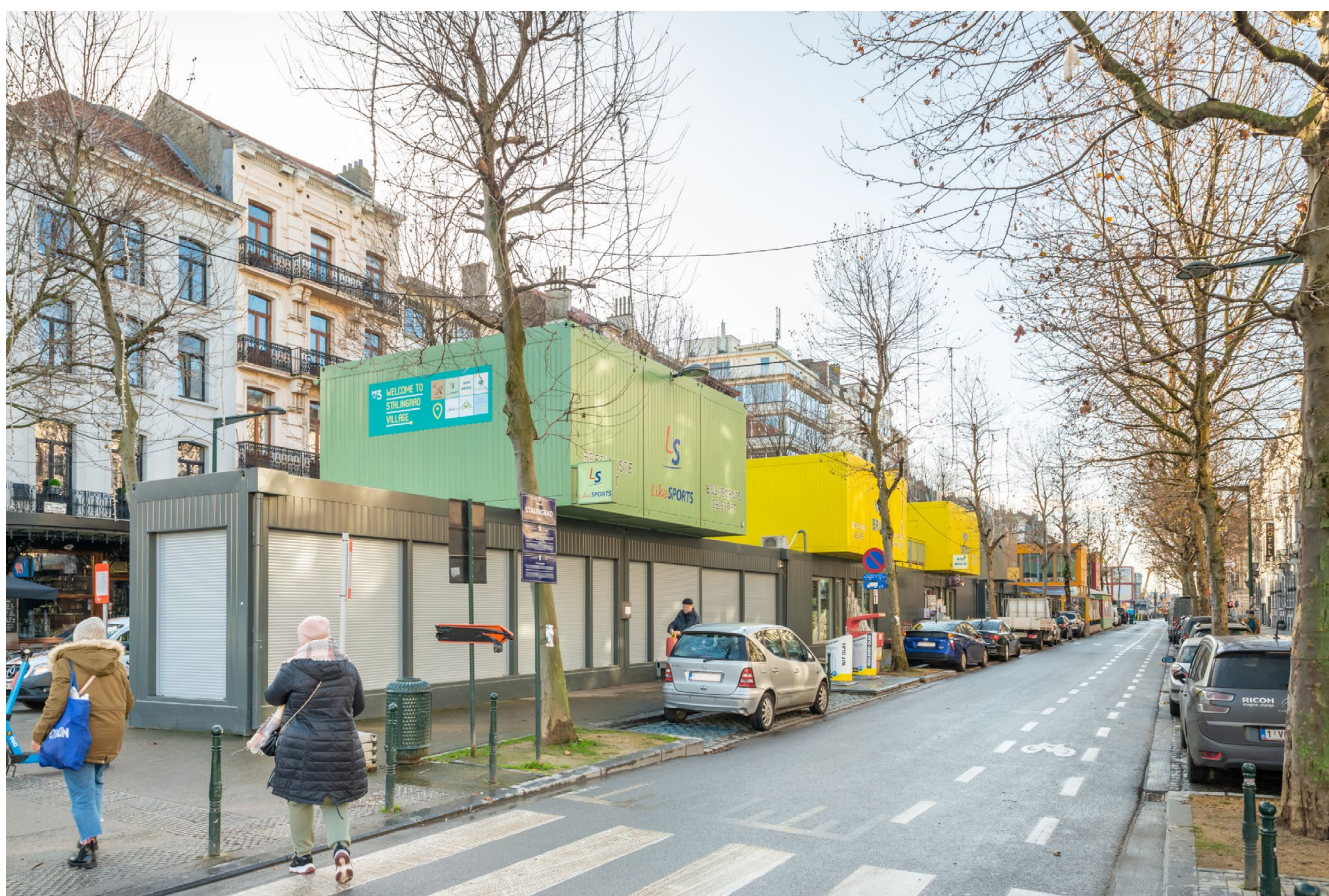
↑ Installation temporaire de containers accueillant les commerçants de l'avenue de Stalingrad impactés par le chantier du Métro 3. Tijdelijke installatie van containers voor de handelaars van de Stalingradlaan die door de bouwplaats van Metro 3 worden getroffen.
