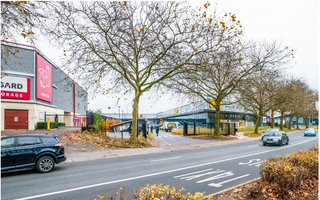
↑ Démolition d'immeubles de bureaux et construction d'un retailpark de 4 000 m 2 à Evere. Sloop van kantoorgebouwen en bouw van een retailpark van 4 000 m 2 in Evere.
