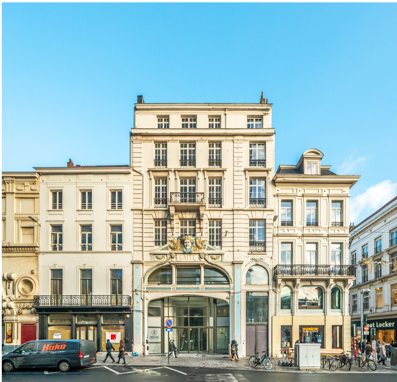
↑ Transformation de la maison culturelle flamande-marocaine, sise à proximité de la rue Neuve, en une surface commerciale de 1 800 m 2 . Verbouwing van het Vlaams-Marokkaanse cultuurhuis, gelegen in de buurt van de Nieuwstraat, tot een handelsoppervlakte van 1 800 m 2 .
